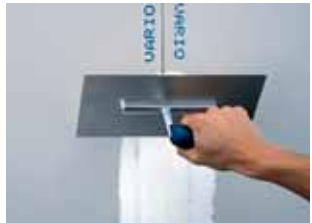
Spachteln ohne Rigips Bewehrungsstreifen
